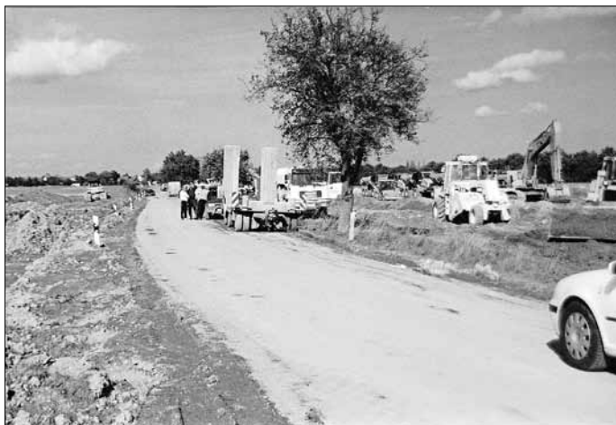
Baugeräte rollen an 08.10.2001
