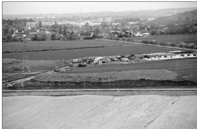
Bis Ende April war der Industriepark eingeebnet
