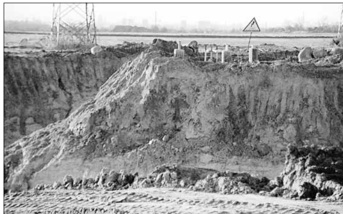
Massenweise wird Erde abgetragen 31.10.2001
